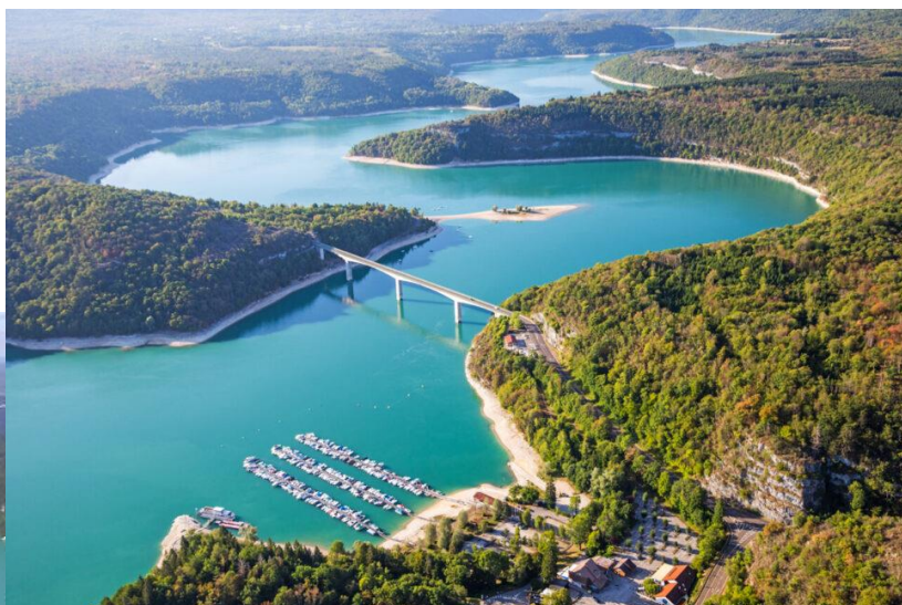
Pont de la Pyle
